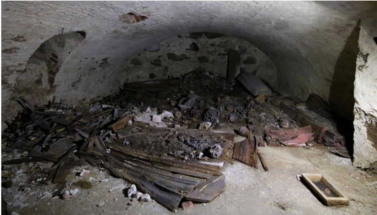
Ryc. 49. Piaseczno. Krypta pod kaplicą Matki Boskiej Szkaplerznej (Krypta S), stan przed wykonaniem prac porządkowych (fot. D. Grupa)
