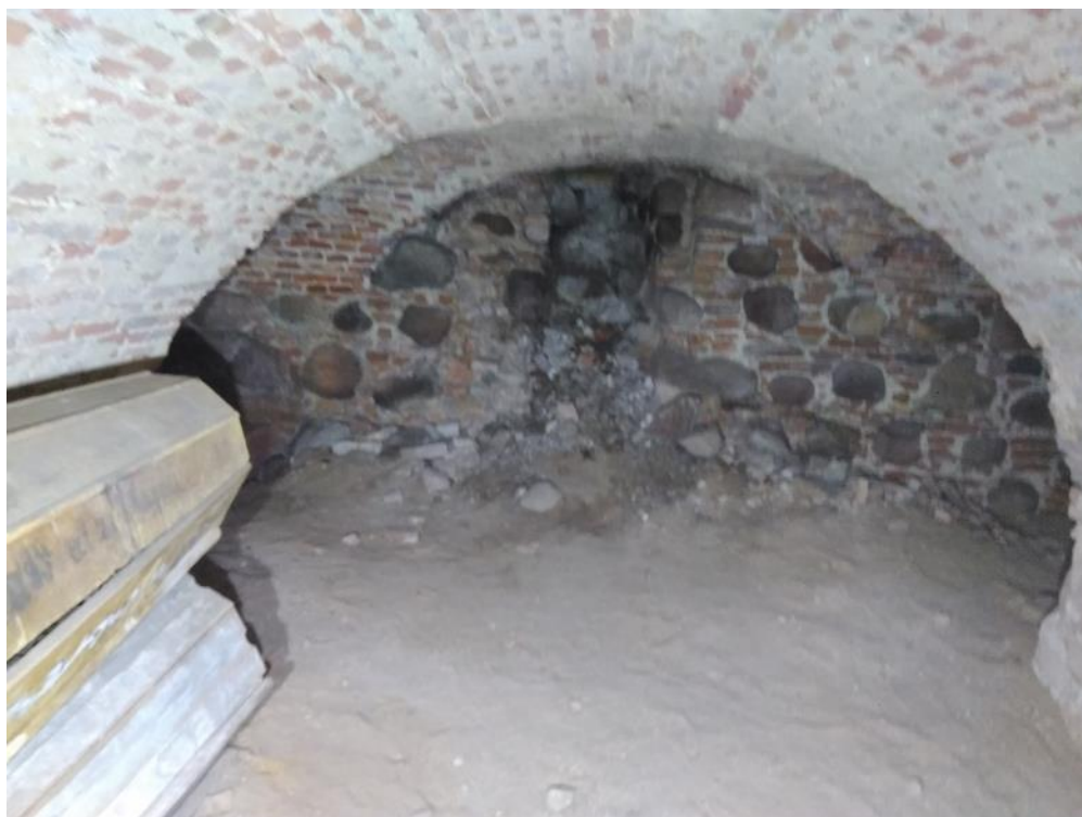
Ryc. 34. Szczuczyn, kościół pw. Imienia NMP Krypta pod nawą zachodnią, stan po pracach porządkowych (fot. J. Michalik)
