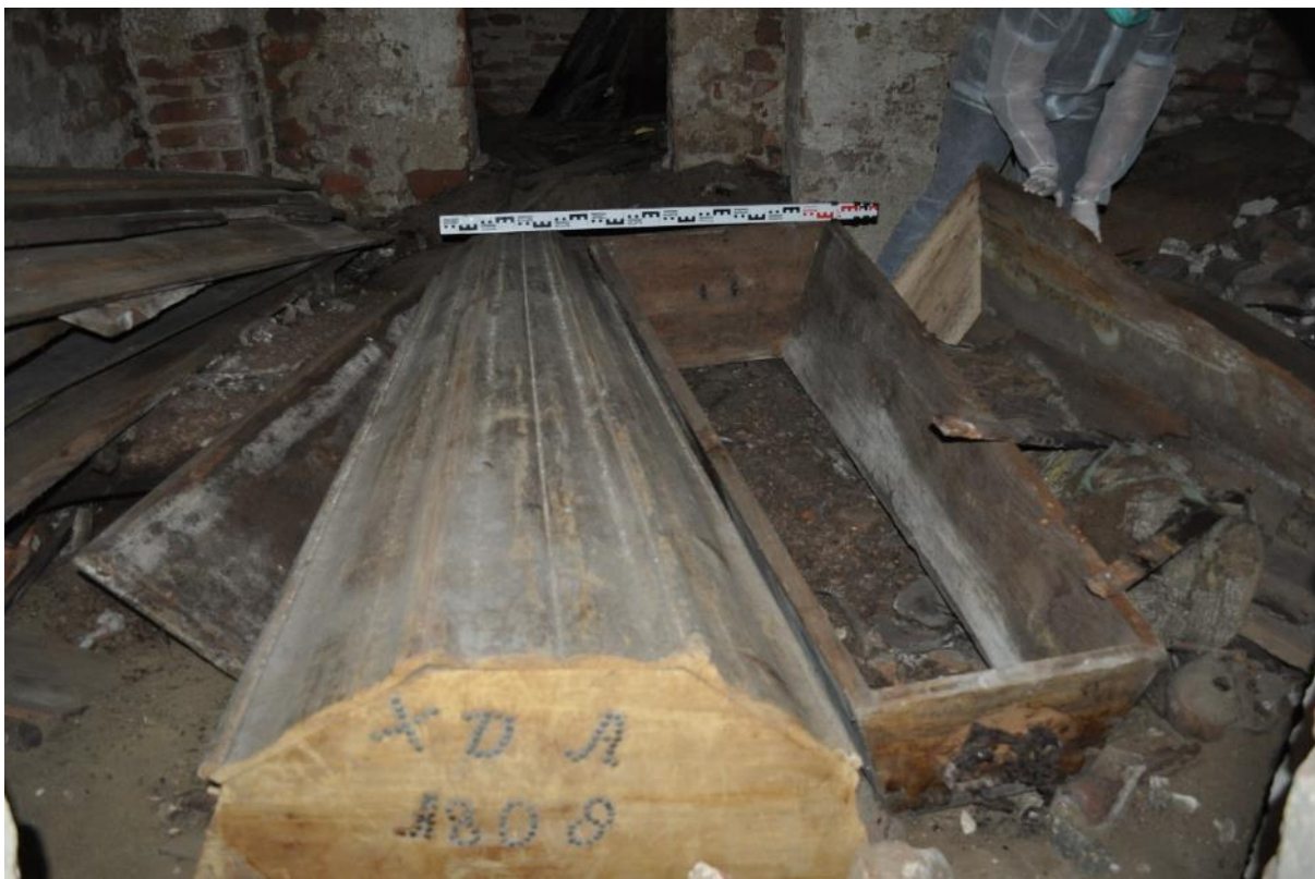
Ryc. 46. Piaseczno. Wnętrze krypty pod prezbiterium, stan przed wykonaniem prac porządkowych (fot. D. Grupa)
