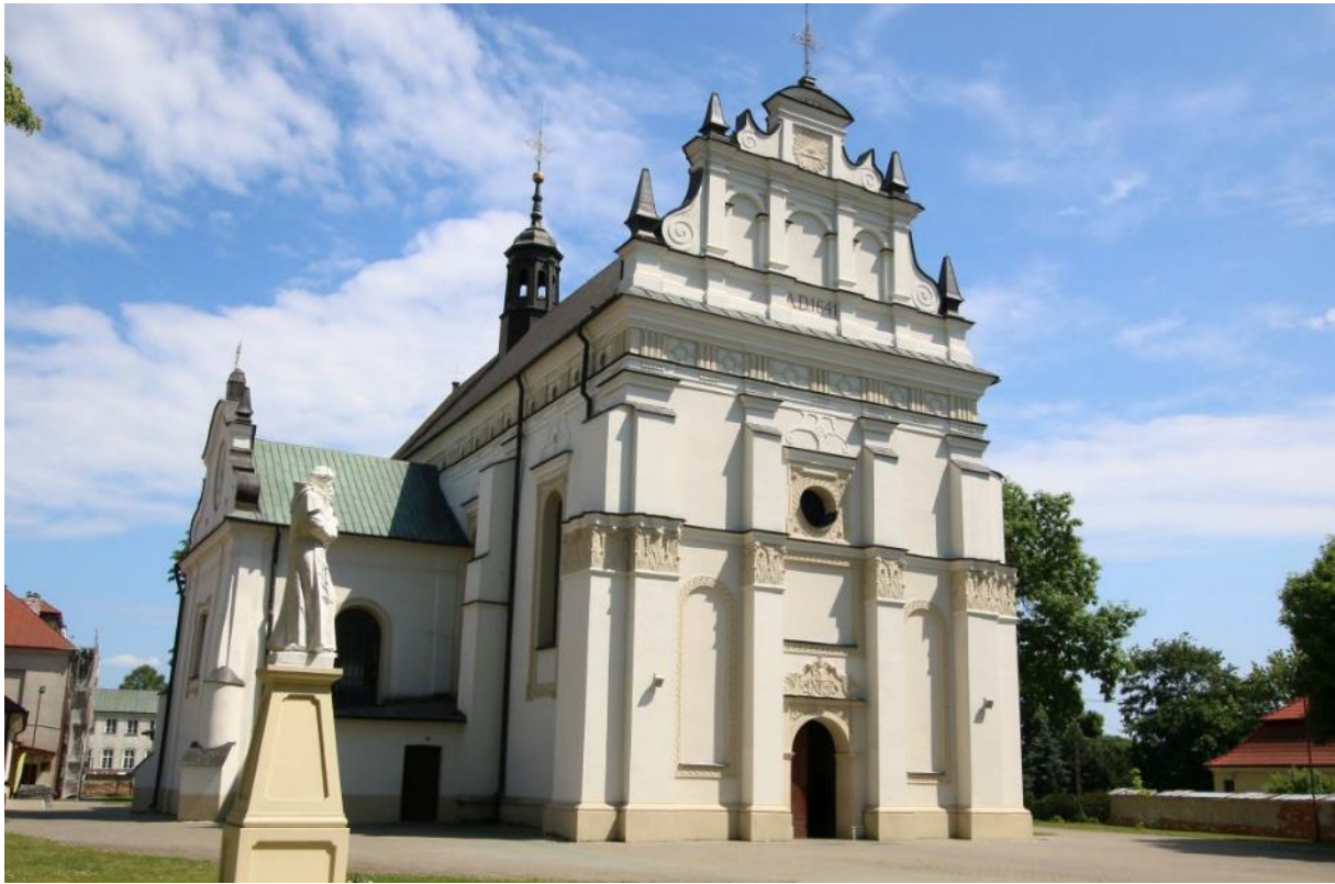
Ryc. 50. Radzyń Podlaski. Kościół pw. Świętej Trójcy (fot. T. Dudziński)
