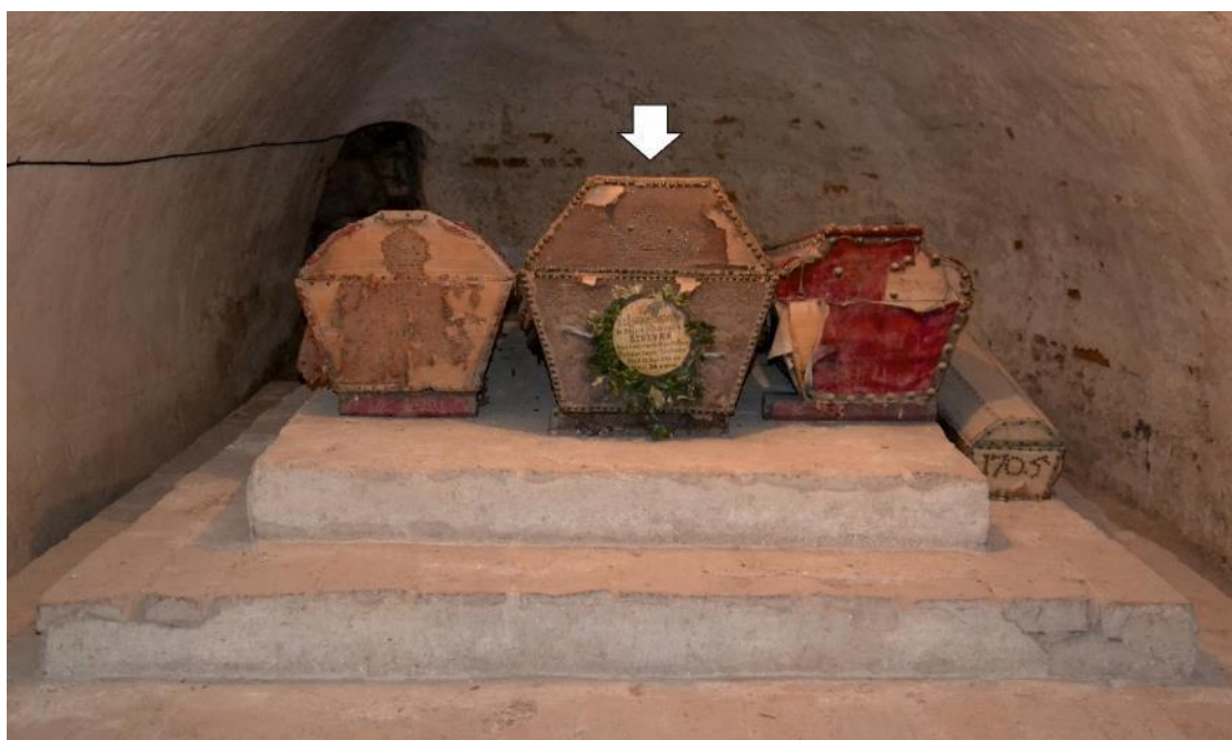
Ryc. 33. Szczuczyn, kościół pw. Imienia NMP; Krypta zachodnia pod prezbiterium, część główna, stan po pracach porządkowych. Strzałka wskazuje trumnę Stanisława Szczuki (fot. M. Majorek)
