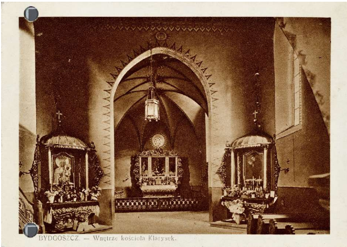
178. Wnętrze kościoła Klarysek, widok na prezbiterium z ołtarzem głównym i ołtarze boczne Romana Skręta, po 1927
