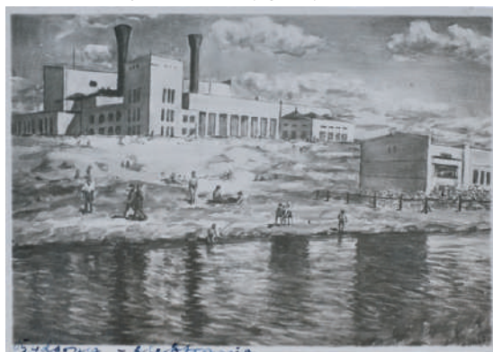
101. Stefan Szmaj, Elektrownia w Bydgoszczy, 1932 (?)
