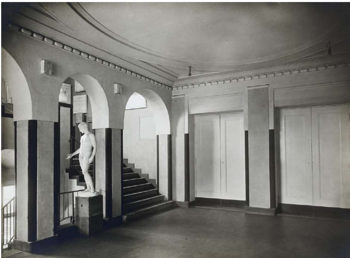
23. Wnętrze Kunstgewerbeschule – korytarz na II piętrze, wejście do auli, 1911-1918
